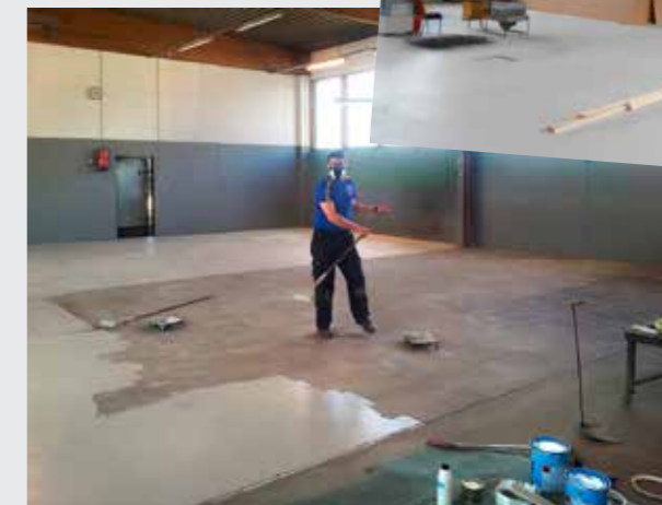
Isäntä itse talkoissa, Henri Kauppi telan varressa. Monnankadun monimerkkikorjaamon lattia sai epoksimaalipinnoitteen. Samalla tavalla pinnoitettiin Ford/Subaru-korjaamon lattia Metallitiellä.
